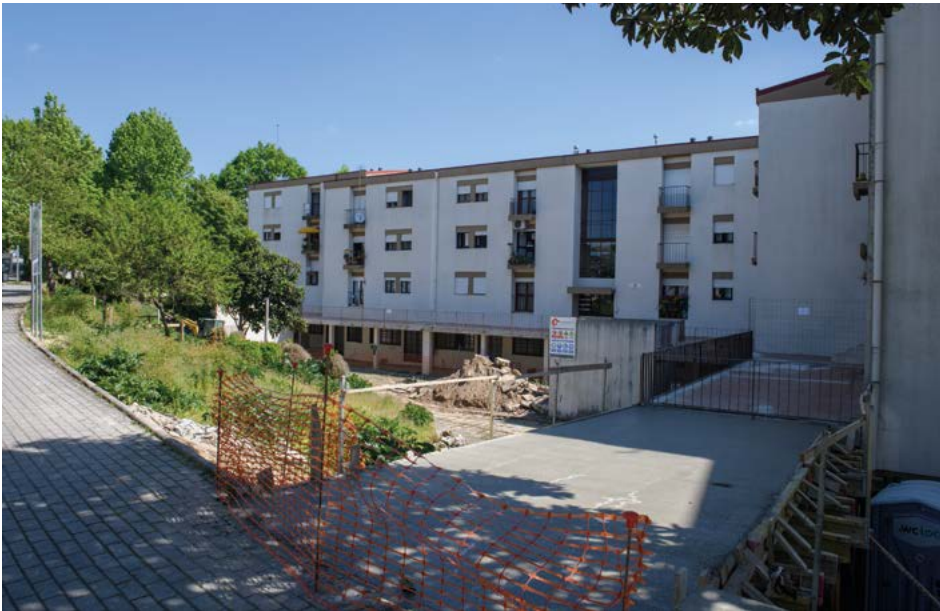
Requalificação e pavimentação das ruas e espaço público, adjacente ao Bairro da Chentuda. (S. Gonçalo)
