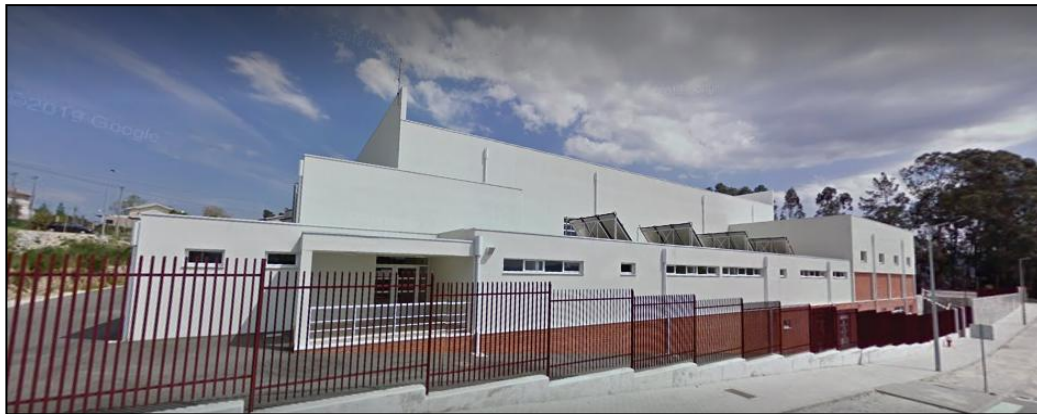
Figura 98- Instalações Pavilhão Municipal de Vila Caiz
