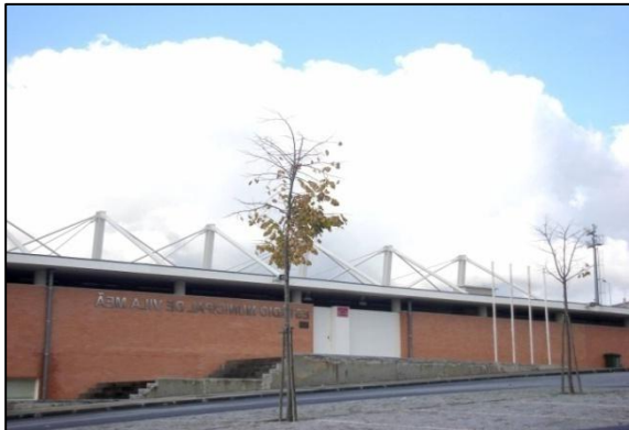
Figura 101- Instalações Estádio Municipal de Vila Meã
