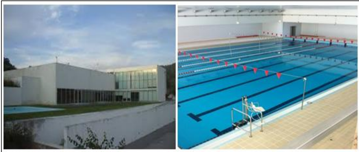
Figura 103- Instalações Piscinas Municipais de Vila Meã
