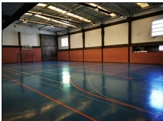
Figura 51- Pavilhão EB23 Marão
