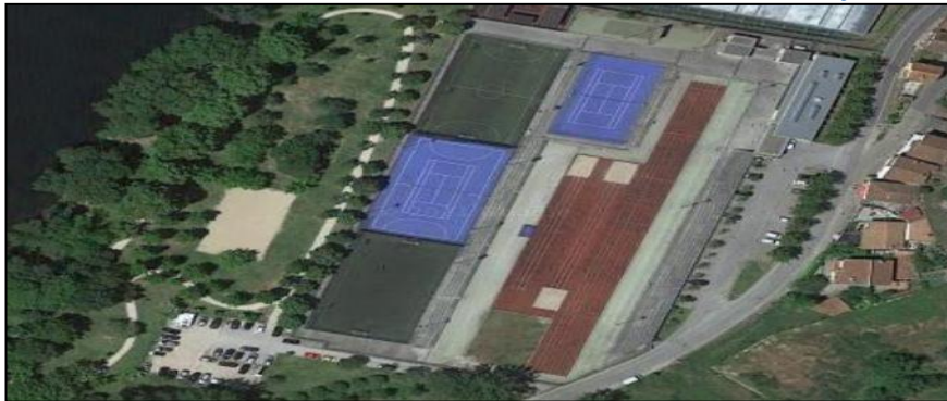
Figura 61- Instalações do Complexo Desportivo da Costa Grande
